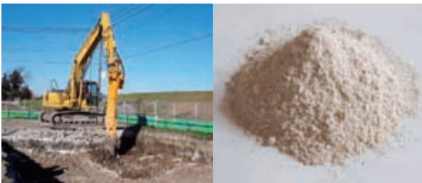
不溶化工事施工状況
