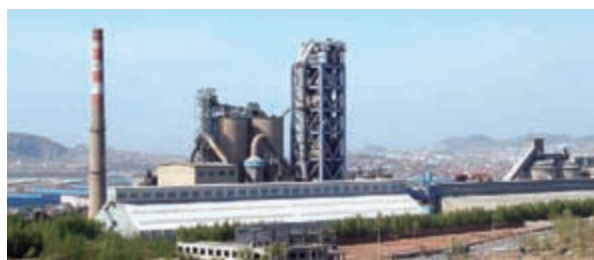
クリンカ置場の密閉化
