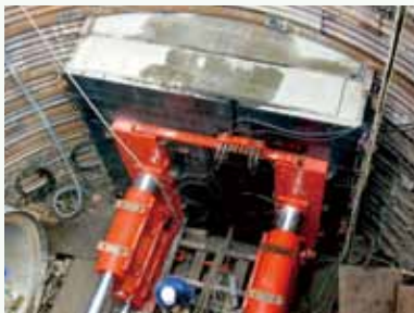
秩父コンクリート工業(株) 「バックロック」(公共下水道工事：東京都)
