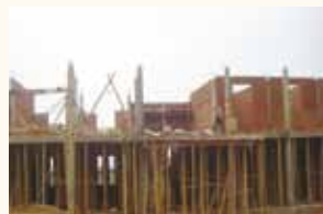
建設中の病院
