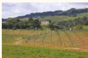
ゲイリー骨材プラントの採掘場
