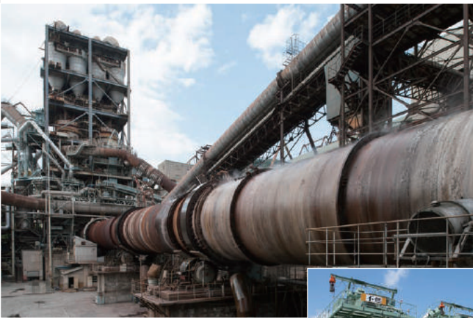
高台にあり、津波被害を逃れた5号キルンが、災害廃棄物処理を支えた
