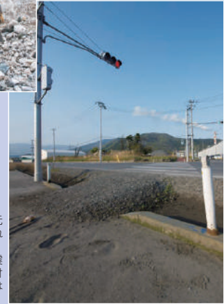
震災で沈下した地盤を元通りにするため、土を入れてかさ上げされた道路 2011年度の供給量は、震災前年と比較して、路盤材は2.5倍、港湾用の沈石は17倍にのぼった
