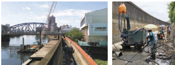
「NJP-2way工法」による隅田川防潮堤耐震対策工事
