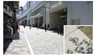
神田駅周辺道路の施工事例
