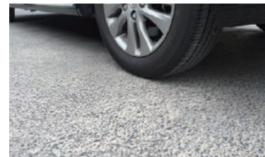
「チチブカラースタッフ-エコ」の工場敷地内での施工事例
