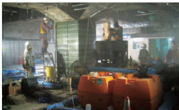
耐震補強工事の施工事例
