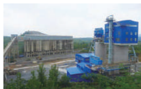
環境負荷低減のため改造した骨材プラント
