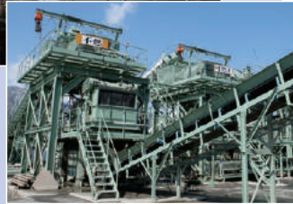
当時、塩分対応のため導入された除塩設備
