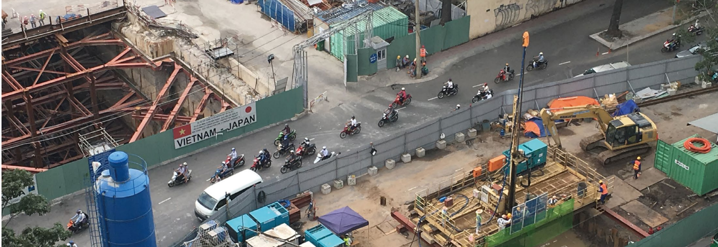
ベトナム地下鉄工事(地盤改良)
