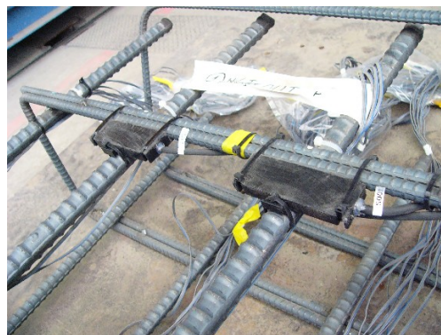
コンクリート配筋に設置した RFID タグ (RFID タグを介して外部と通信)
