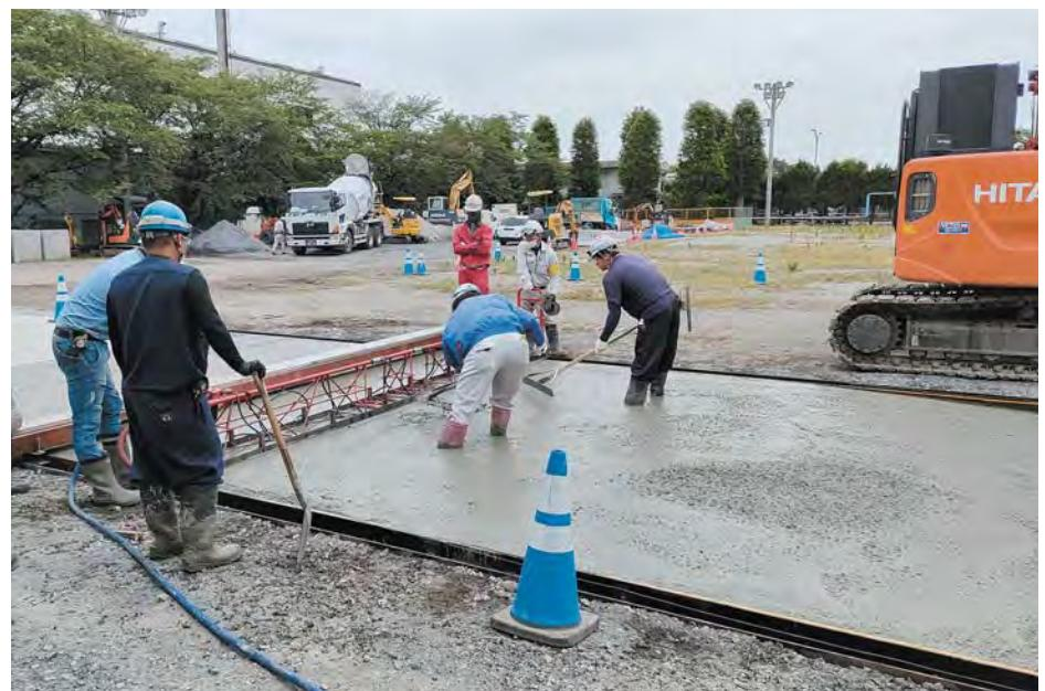
写真-3 カーボキヤッチスラリーを適用したコンクリート舗装の施工状況
