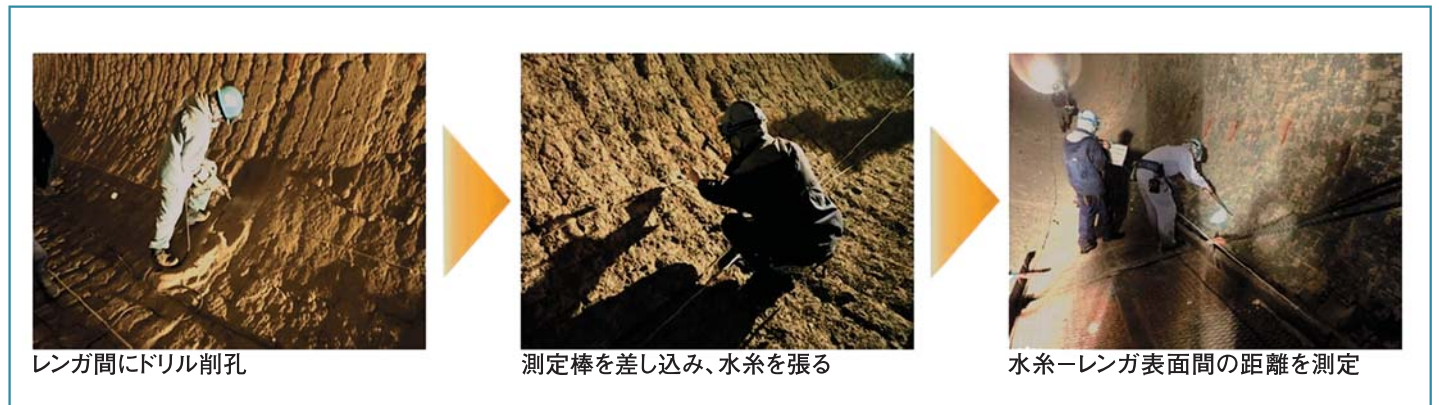
図-3 従来のレンガ残厚測定
