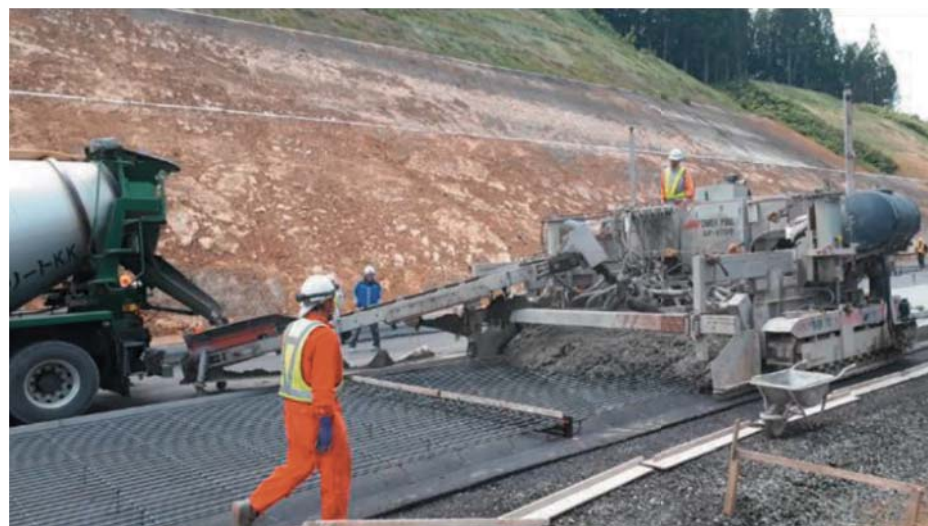
写真-3 ニツ井今泉道路における連続鉄筋コンクリート舗装の施工
