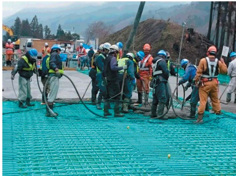
写真-2 向定内橋の施工
