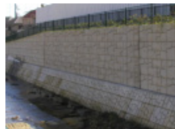
写真 2 竣工後 6 ヶ月の状況
