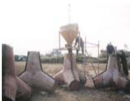
写1 消波ブロック施工状況
