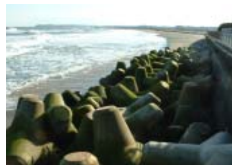
写2 消波ブロック（施工後1年）
