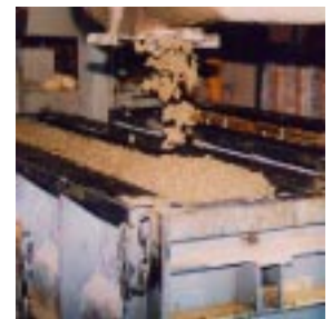
写真-1 打設状況
