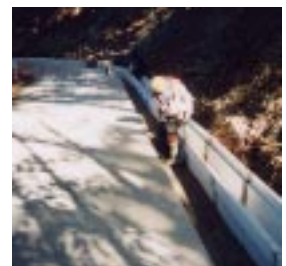
写真-2 施工状況
