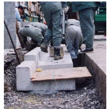
写真-1 試験施工状況
