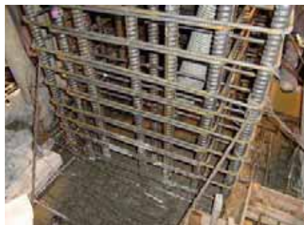
写真-2 施工状況(物件E)
