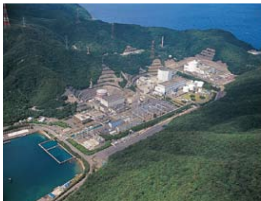
敦賀原子力発電所
