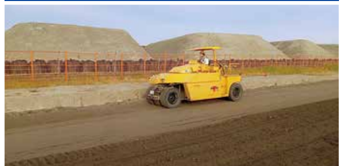
ローラーによる転圧
