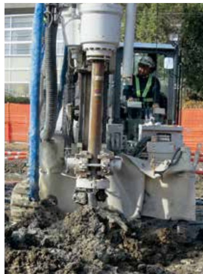
柱状改良による施工状況
