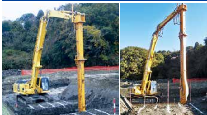
スラリー揺動攪拌混合機による改良
