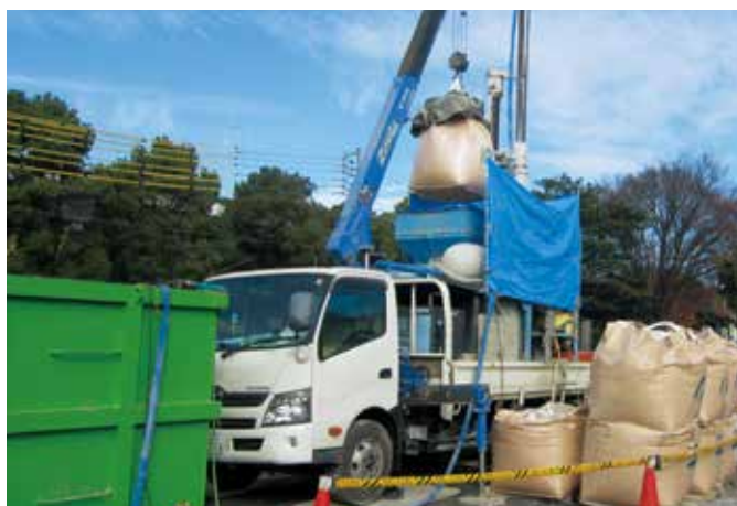
固化材(フレコン)投入状況
