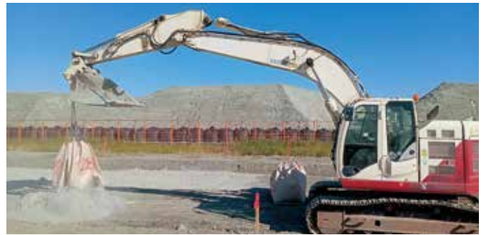
固化材(フレコン)の散布状況
