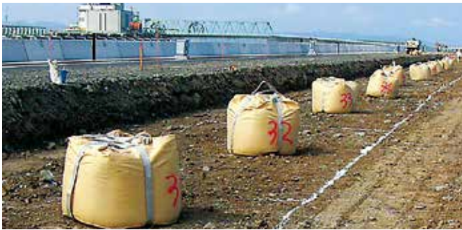
固化材(フレコン)の配置状況
