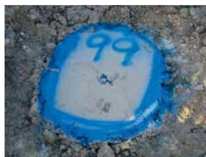
改良体杭頭の確認
