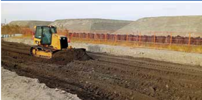
ブルドーザーによる整正
