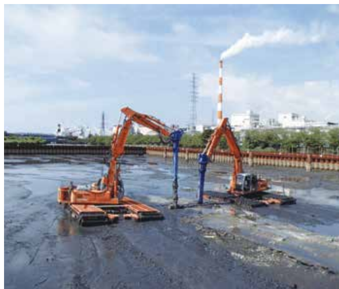
泥上車による改良状況
