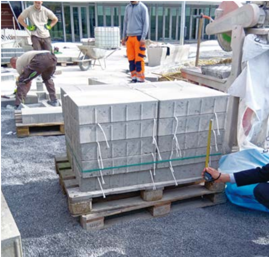
左／ドイツ視察研修会 bauma2025(建設機械展)視察の様子 右／ドイツ視察研修会 ブロック舗装の施工状況視察
