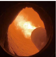
セメントキルン内でのクリンカ焼成
