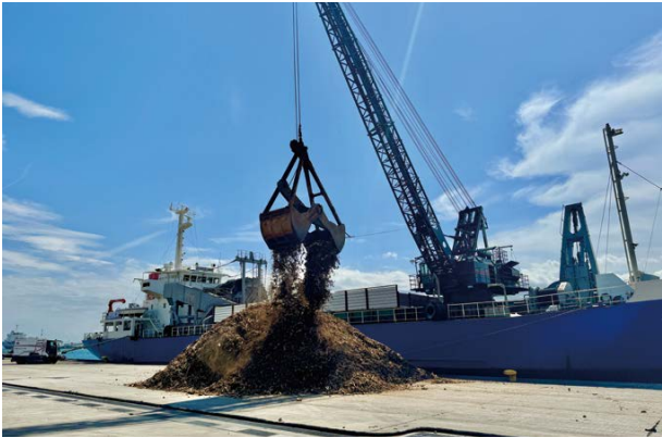
新潟県姫川港における能登半島地震の災害廃棄物(木くず)荷揚げの様子
