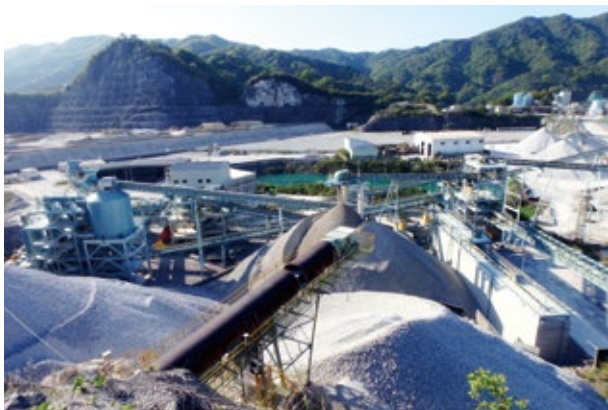
骨材水洗プラント(新津久見鉱山)
