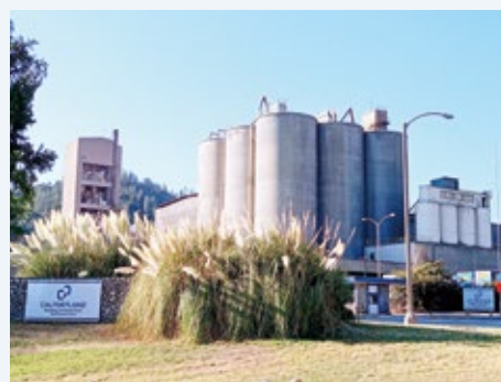
カルポルトランド社 レディング工場
