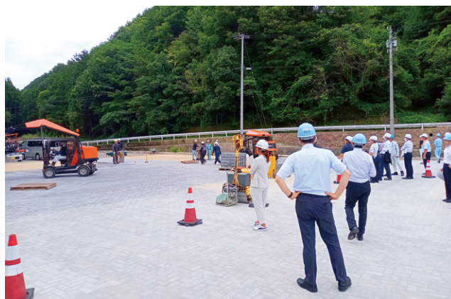
機械施工見学会の様子
