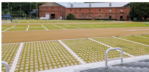
ブロックの間に芝生を植栽することでヒートアイランド現象の抑制効果を生み出す緑化ブロック（太平洋プレコン工業社）
