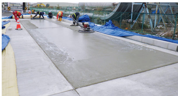
カーボキャッチスラリーを使用したコンクリート舗装の試験施工
