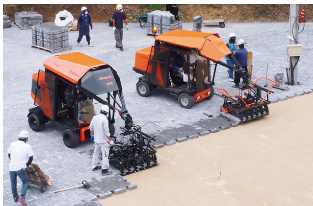
ドイツ製のインターロッキングブロック専用敷設マシン
