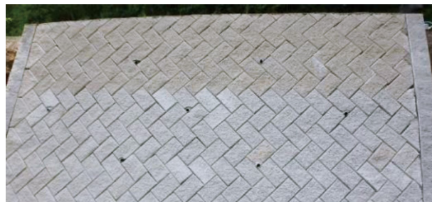
カーボフィクスセメントを使用したコンクリート製品の現場施工
