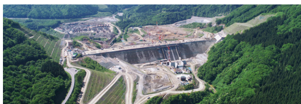
成瀬ダム建設現場(2024年5月撮影)
