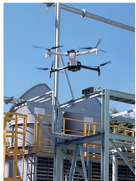
ドローンによる設備点検
