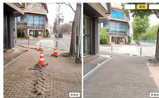
適用例 崩れた舗装ブロックの再敷設によるリユース(東日本大震災など)
