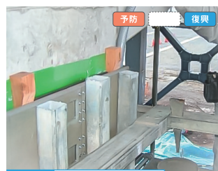
適用例 被災後の耐震補強
