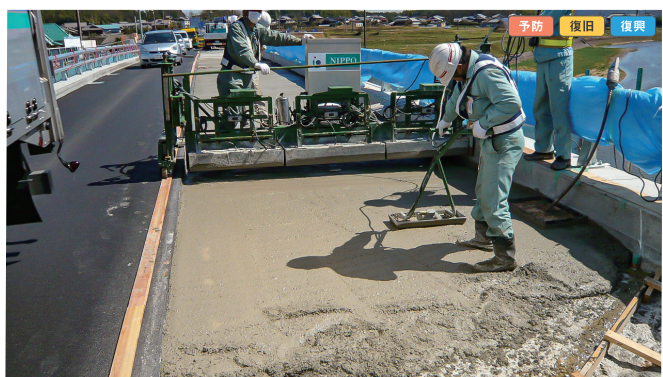
適用例 被災した橋梁の床板や工場の土間の補修
