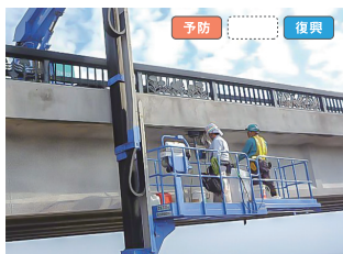
適用例 構造物の被災状況の点検
