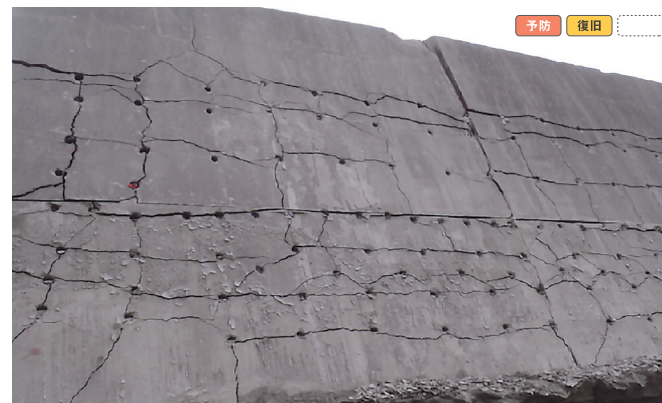
適用例 被災構造物の破砕、落石撤去
