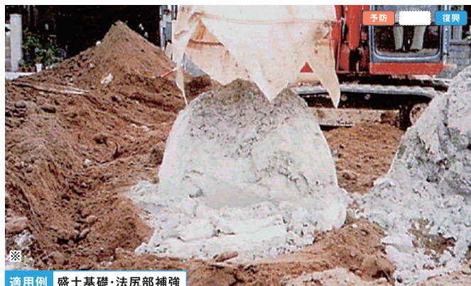
適用例 盛土基礎・法尻部補強
