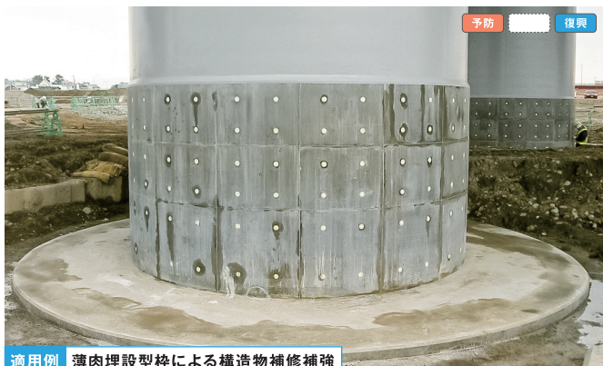
適用例 薄肉埋設型枠による構造物補修補強
