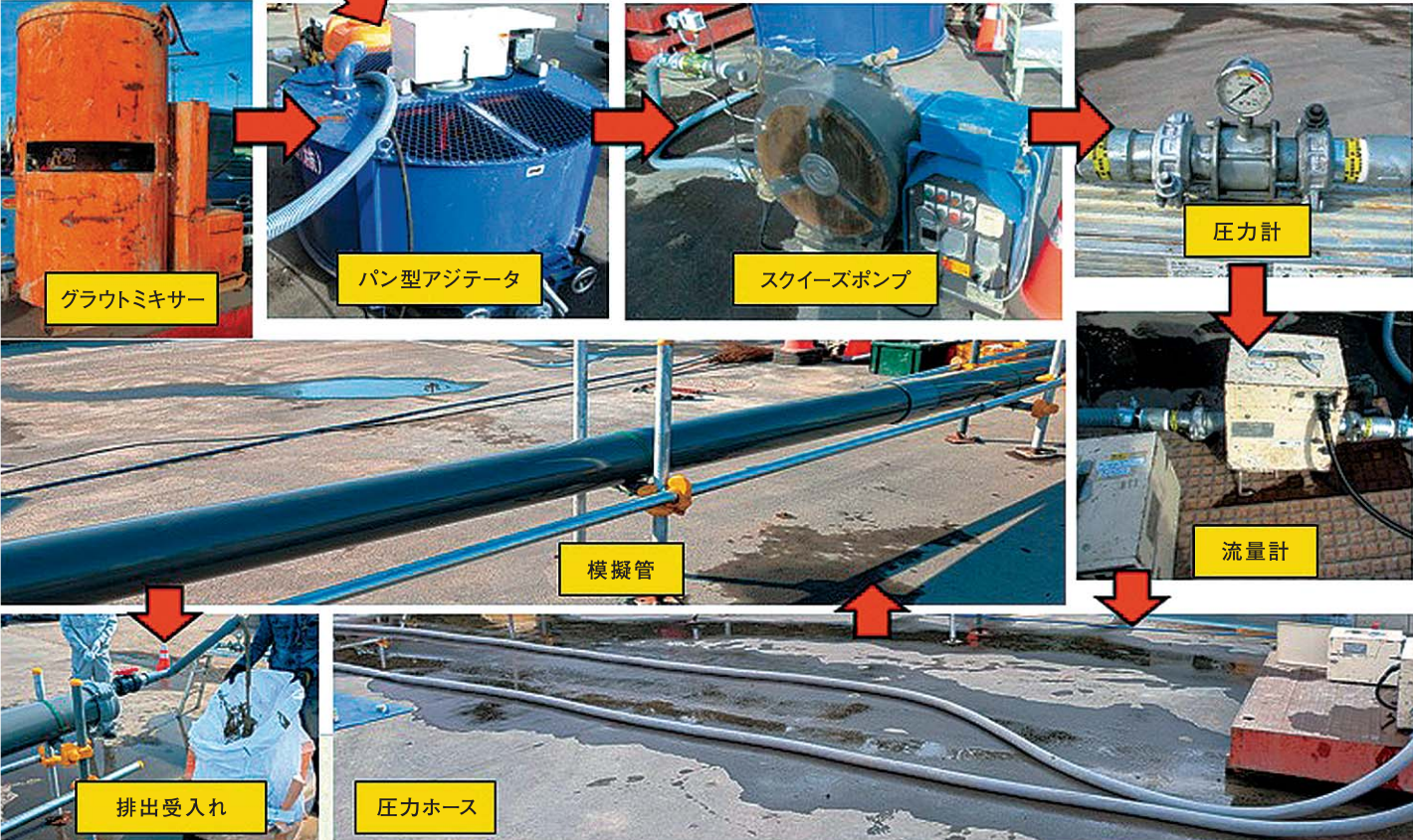
写真-8 テスト施工の全体写真
