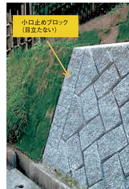
写真-8 小口止めスプリットブロック施工
