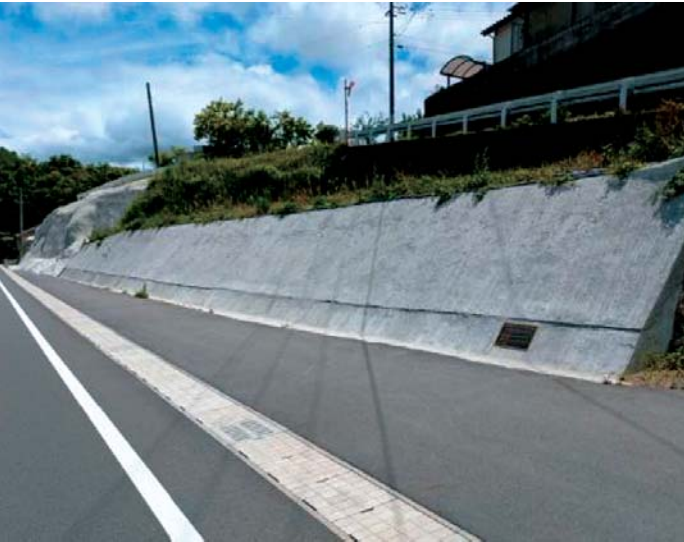
写真-3 張コンクリート工
