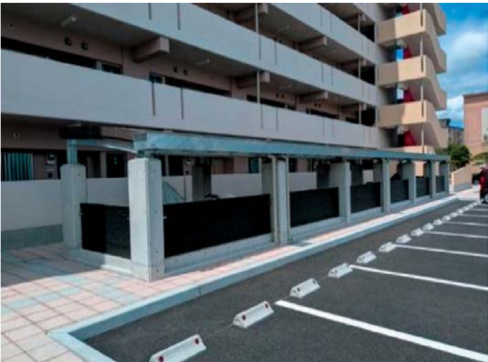
写真-7 県営住宅の駐輪場(VGPコンクリート)
