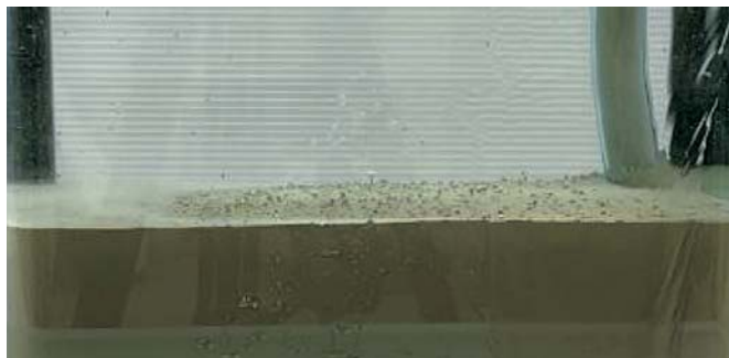
写真-3 レコキープLWの水中打設状況
