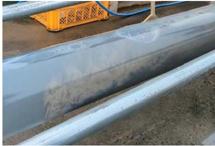
写真-11 レコキープLR-5Nの圧送状況
