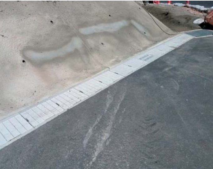
写真-5 落蓋側溝
