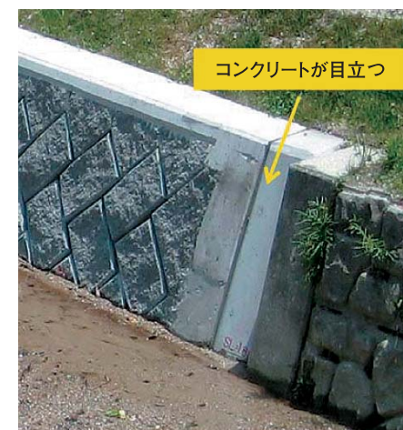
写真-7 従来の小口止め施工
