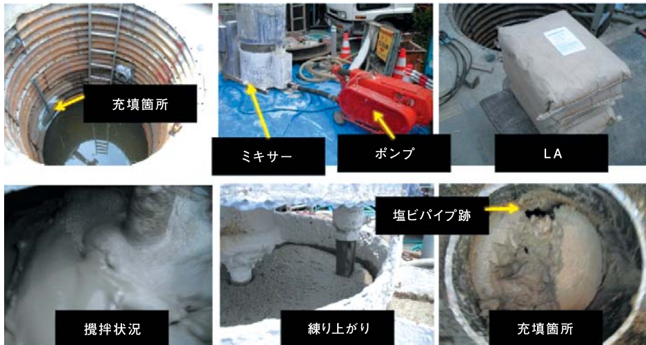
写真-4 レコキープLA施工例(宮城県下水道管路の充填)
