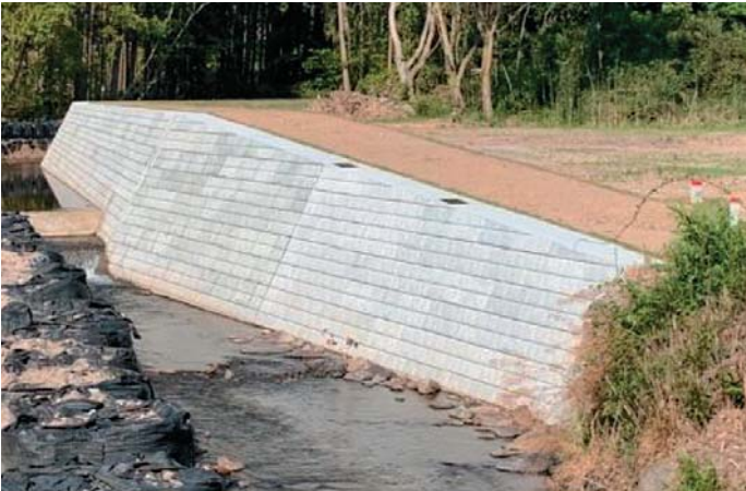
写真-10 護岸工事
