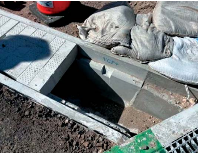
写真-6 VGP刻印入り落蓋側溝を工事中の様子
