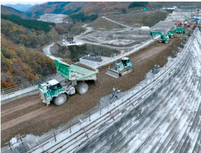
図-11 フライアッシュCSG打設状況
