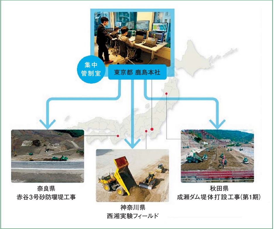
図-6 遠隔集中管制による施工
