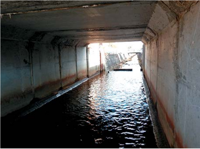
写真-2 内空断面
