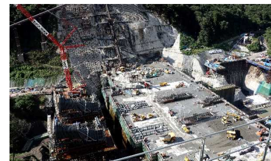
ハッ場ダム建設現場
