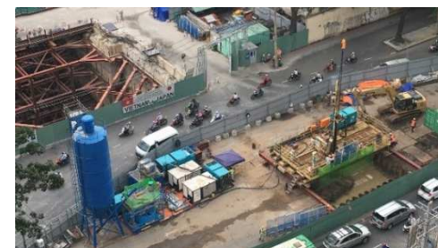
ベトナム 地下鉄工事（地盤改良）
