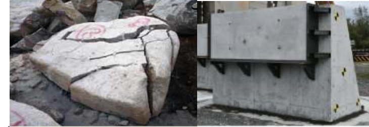
落石の破碎 ブライスター (静的破碎剤)
