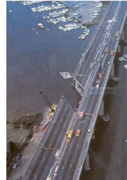
コネチカット州マイアナス橋の崩落 (1983年)
