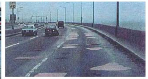
【有料橋の床版補修】
