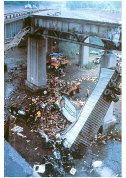
コネチカット州マイアナス橋の崩落 (1983年)
