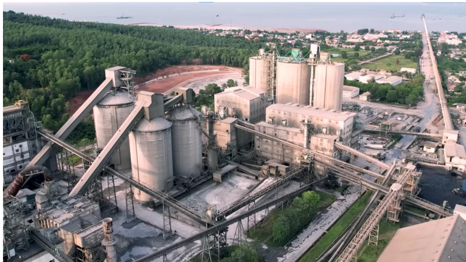
ニャチャン セメント出荷ターミナル (2024年2月竣工)
