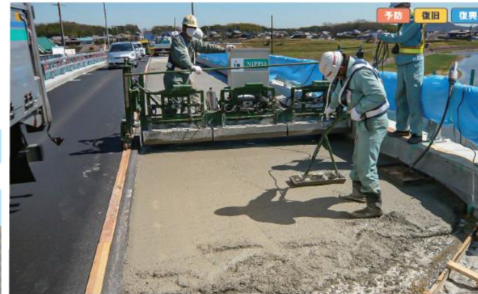
適用例 被災箇所の補修
