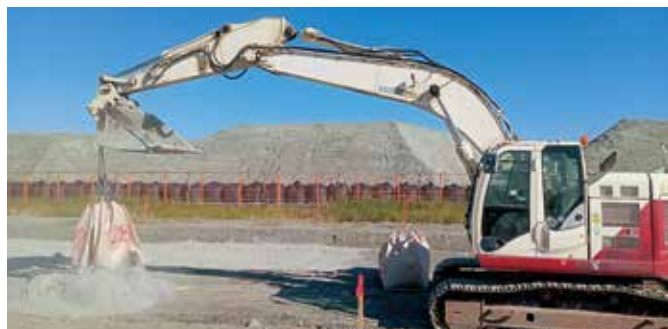
固化材 (フレコン) の散布状況
