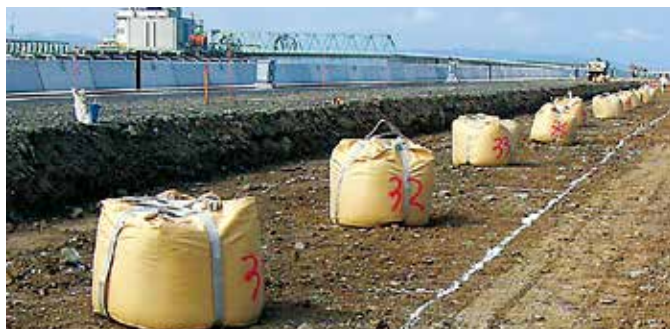
固化材 (フレコン) の配置状況
