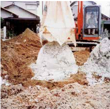
PTFE処理防塵型固化材
