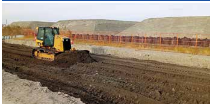
ブルドーザーによる整正
