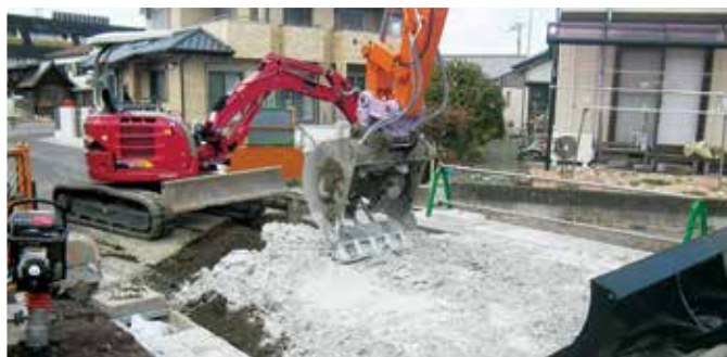
混合機付きバックホウによる混合
