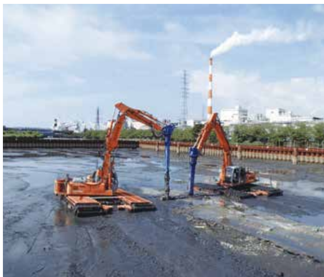
泥上車による改良状況
