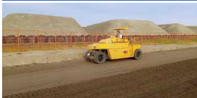
ローラーによる転圧
