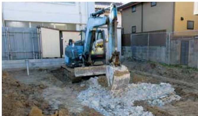
バックホウによる敷均し状況(使用固化材:防塵型固化材)
