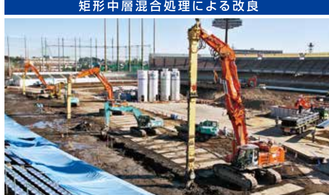
矩形中層混合処理による改良
