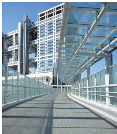
製品：遮熱性 ILB（インターロッキングブロック） 施工場所：お台場中央連絡橋
