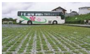
大型車両向け駐車場の施工事例
