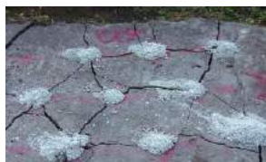
施工後の亀裂発生状況
