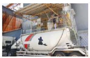
昇降階段+セフティーブロック+フルハーネス安全帯
