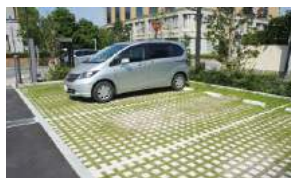
駐車場の施工事例
