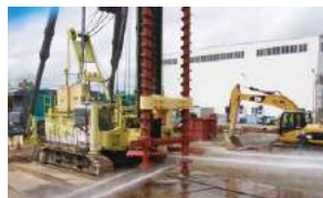
SDM-Fit IV型工法
