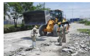
道路を補修する従業員
