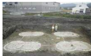
地盤改良状況
