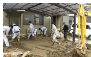
復旧作業にあたる従業員
