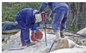
充填施工状況
