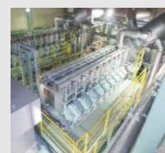
熊谷工場ガスエンジン
