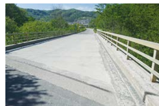
LMFC®でコンクリート舗装された道路橋(北海道北斗市)
