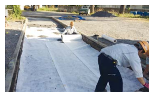
ILBイーजीジオフィルター敷設状況
