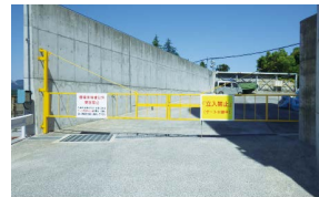
重機作業範囲の明確化工事(藤原工場)
