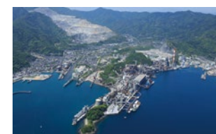
太平洋セメント(株)大分工場
