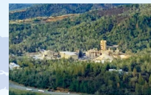
CalPortland Company, Redding Plant (米国・レディング)
