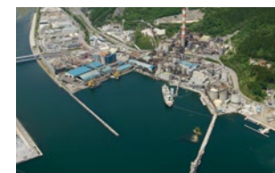
太平洋セメント(株)大船渡工場
