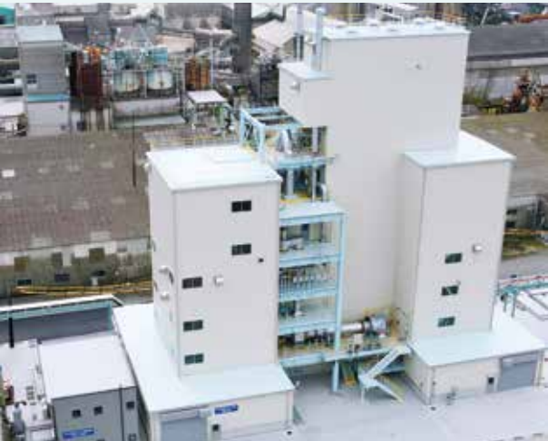
C2SPキルン実証試験設備（山口県山陽小野田市）
