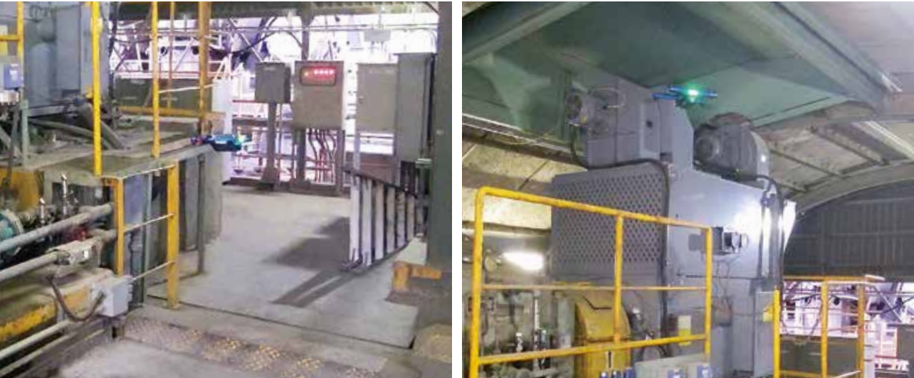
ドローンによる設備点検(熊谷工場)
