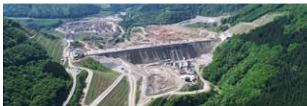
成瀬ダム建設現場 (2024年5月撮影)
