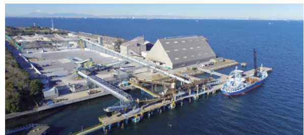
南袖骨材ヤード
