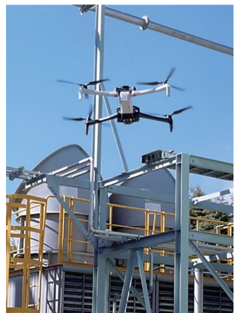
ドローンによる設備点検
