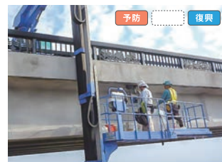
適用例 構造物の被災状況の点検
