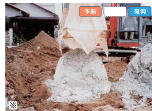
適用例 盛土基礎・法尻部補強
