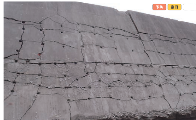
適用例 被災構造物の破砕、落石撤去
