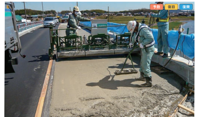
適用例 被災箇所の補修
