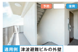
適用例 津波避難ビルの外壁
