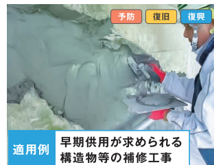
適用例 早期供用が求められる構造物等の補修工事
