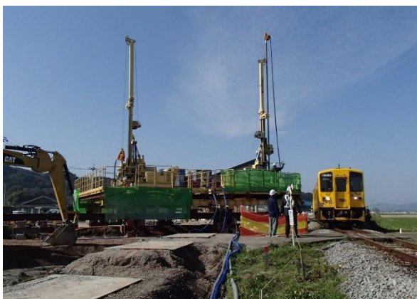
鉄道近接地での地盤改良工事「LDis工法」
