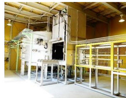
リチウムイオン電池 焙焼リサイクル設備（敦賀セメント㈱）
