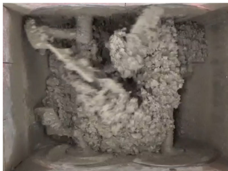
練り混ぜ中の生コンクリート
