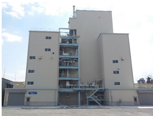
実証試験設備の外観
