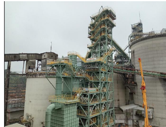
分級設備設置中の佐伯アッシュセンター（2024年6月完成予定）
