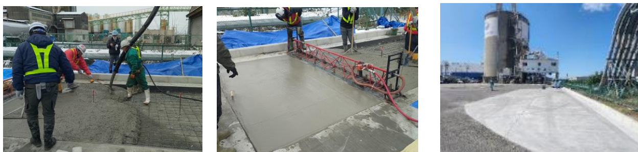
図3 カーボキャッチスラリーを使用した舗装コンクリートの施工状況と供用状況
