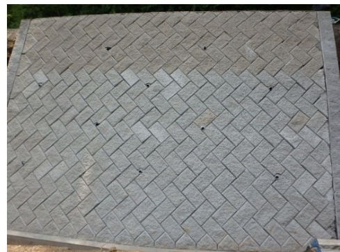
写真2 法面復旧工事適用状況
