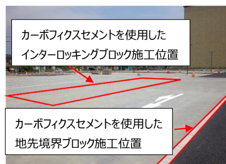
写真2 駐車場工事への適用状況
