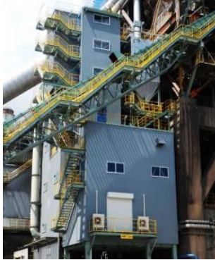
塩素バイパスシステム。廃プラ等利用に起因する塩素の増加に対して効果を発揮。
