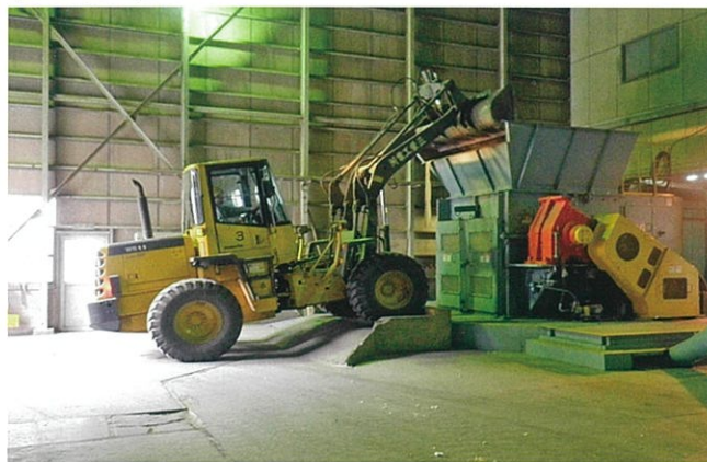
廃プラ処理施設
