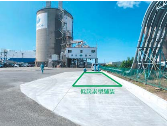
写真-6 供用開始2カ月後の施工現場状況
