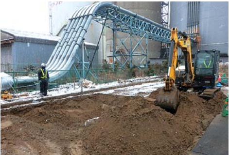
写真-5 施工中の現場状況(左：路床の改良、中央：路盤材の施工、右：舗装コンクリートの打設)
