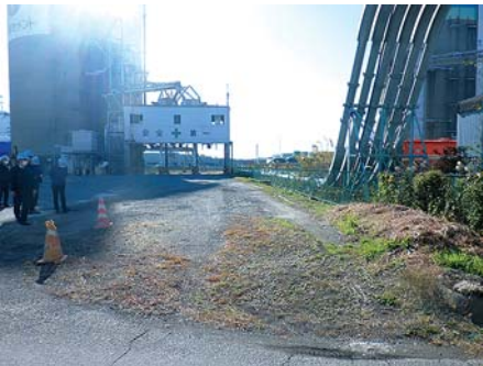
写真-4 施工前の現場状況
